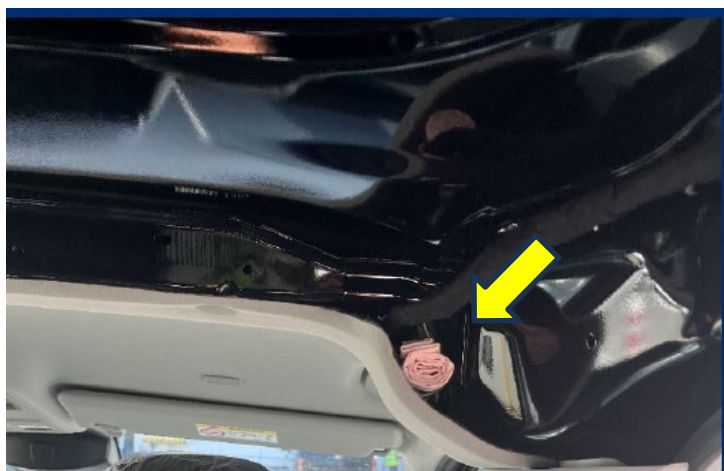
Fig. 1 : revêtement de pavillon au niveau du montant B à droite
